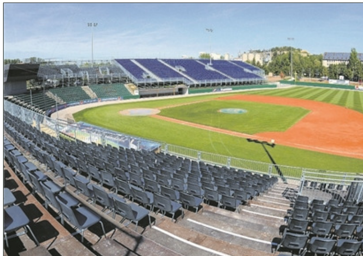
Ein „Hingucker“ der besonderen Art: die Baseball-Arena in Regensburg – die größte in Deutschland. Foto: dpa
